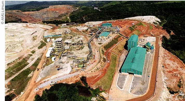
Fig. 2-7. – Vue aérienne des installations de traitement de la mine de Mibra (Brésil), lancées en 2019 par AMG Lithium, qui exploite une pegmatite pour produire des concentrés de spodumène, d'étain et de tantalite.
